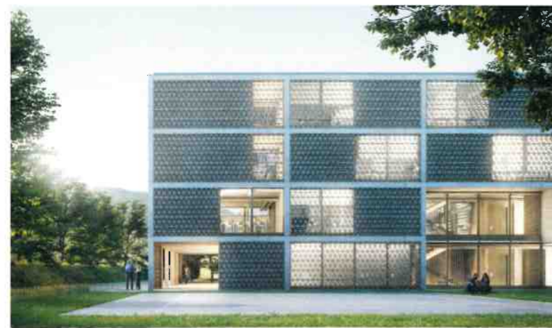
2. Rang, 2. Preis «Camaleonte»: Die modulare Bauweise gibt die Funktion des Gebäudes nicht zu erkennen. Die durchbrochenen Betonfassadenelemente grenzen das Gebäude stark vom Aussenraum ab. Grundriss 1. OG, Mst. 1:700.
