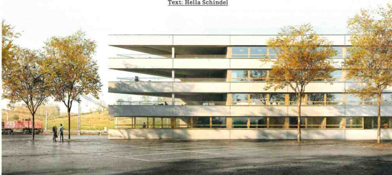
1. Rang, 1. Preis «En même temps»: Die modulare Bauweise aus Betonelementen ermöglicht spätere Umnutzungen. Mit dem kompakten Volumen des stringenten Riegels ist der geforderte Minergie-Standard unkompliziert zu realisieren.
